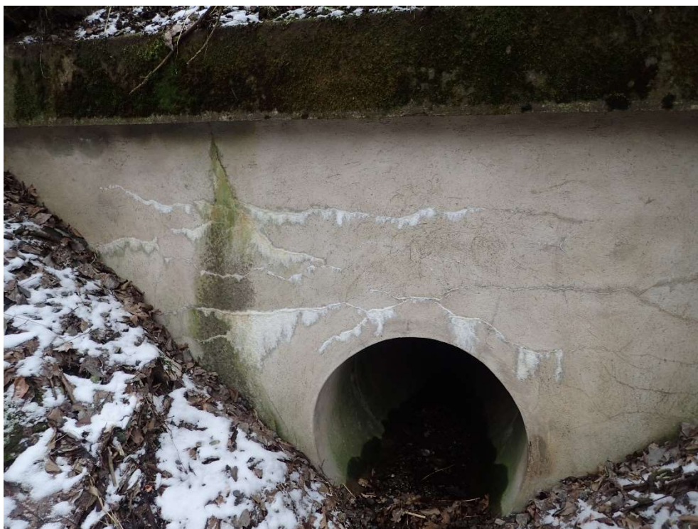
Foto 4: Podélné trhliny, výkvěty
