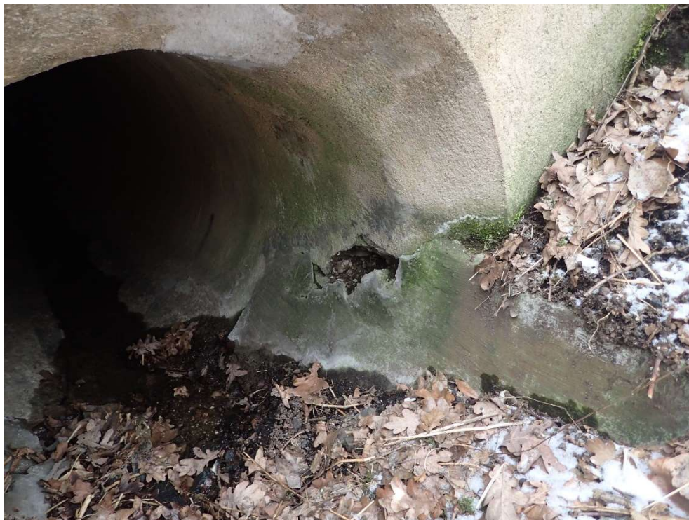
Foto 3: Znamky po vlhkosti, vydrolený beton
